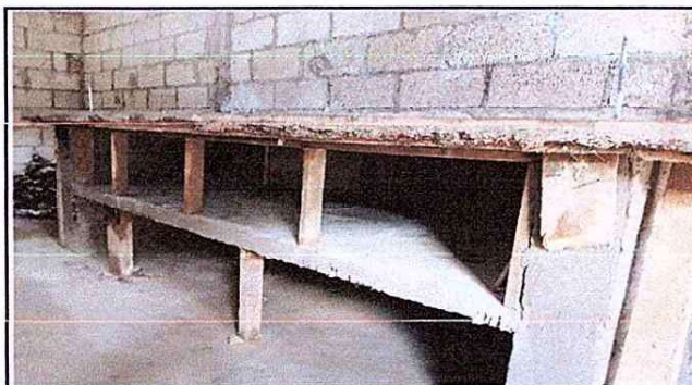
Foto 3: Se observa la construcción del desayunador.
