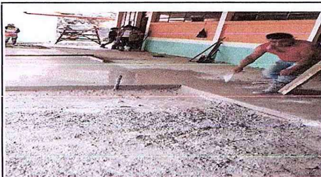
Foto 1: Se observa la colocación de la torta de cemento en el corredor de las aulas.
