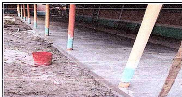
Foto 6: Se observa construcción de los canales pluviales
