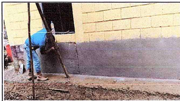
Foto 4: Se observa la colocación de las fachaletas alrededor de las aulas del establecimiento.
