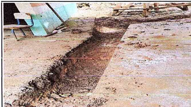
Foto 2: Se observa la colocación de las cunetas de concreto y la bajadas pluviales.
